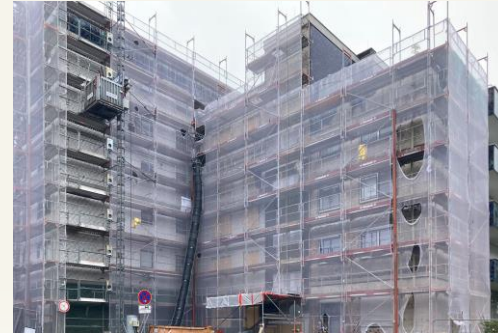
SANIERUNG UND UMBAU
